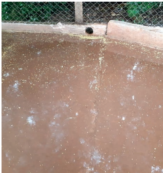
Figura 34. Acúmulo de água na Academia da Terceira Idade (ATI). Fonte: Trabalho de campo (2019) - Lucas C. F. Sant'Ana.
