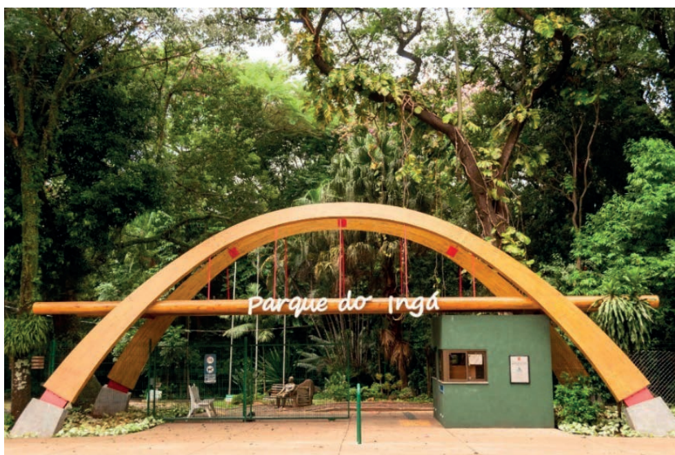
Figura 135. Portal da entrada principal do Parque do Ingá em 2019. Fonte: Acervo da Prefeitura Municipal de Maringá.
