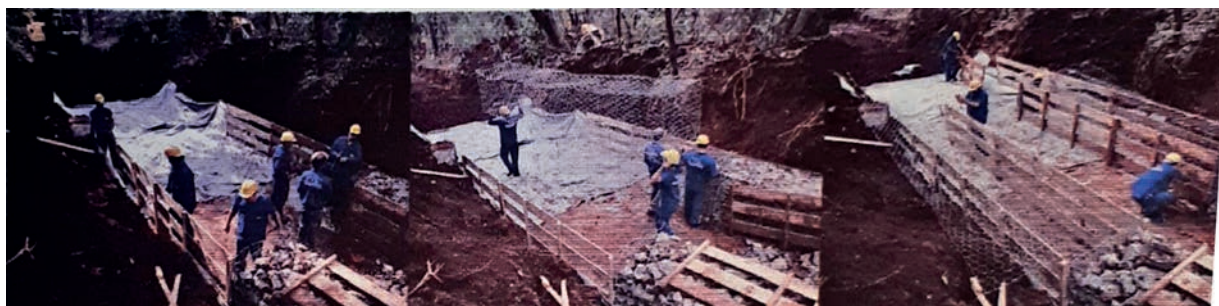
Figura 30. Instalação dos gabiões ao longo do canal Norte-Leste. Fonte: Oliveti (2010).
