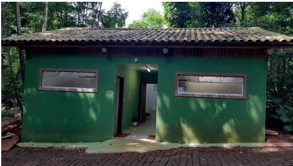
Figura 131. Banheiro com acessibilidade, situado próximo ao parque infantil. Foto: Novakowski (2019).
