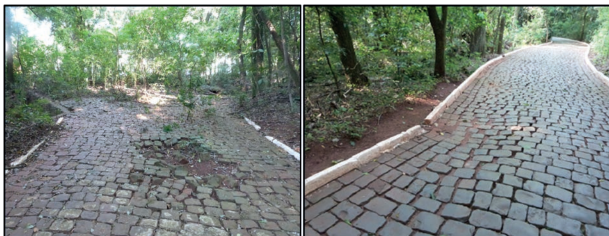
Figura 130. Trechos da trilha do Parque do Ingá onde faltam paralelepípedos (à esquerda) ou há seu desnível (à direita). Fotos: Novakowski (2019).
