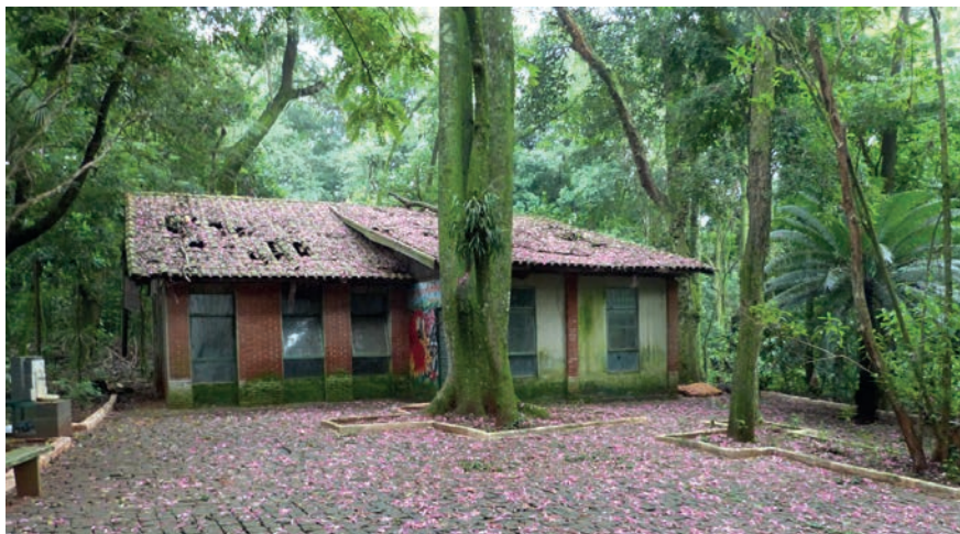
Figura 164. Edificação localizada em uma área potencial para a construção da nova sede administrativa do Parque do Ingá. Foto: Novakowski (2019).
