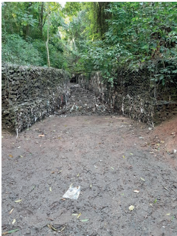
Figura 31. Trecho do canal artificial Leste já retificado com estrutura em gabião. Fonte: Trabalho de campo (2019) - Lucas C. F. Sant'Ana.
