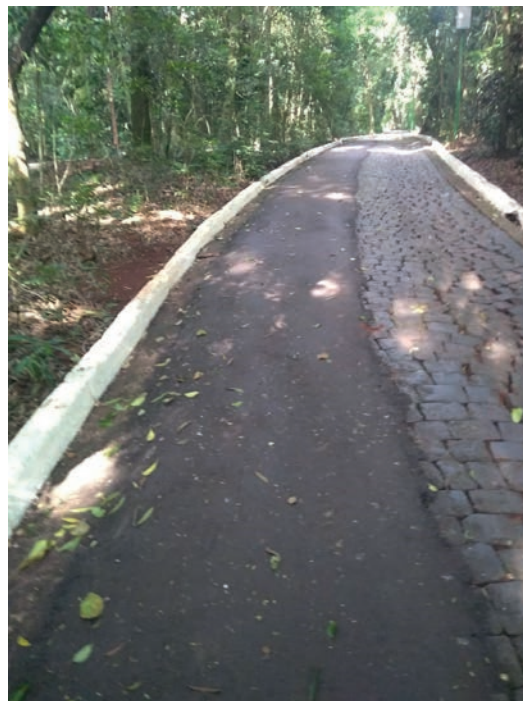
Figura 46. Pista no interior do Parque do Ingá com pavimento misto em asfalto e paver de paralelepípedo. Fonte: Trabalho de campo (2020).
