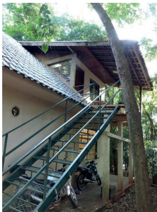
Figura 141. Acesso ao piso superior da sede do setor administrativo do Parque do Ingá.
