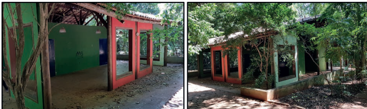
Figura 169. Bilheteria não funcional destinada à gestão das atividades de arvorismo e tirolesa.
