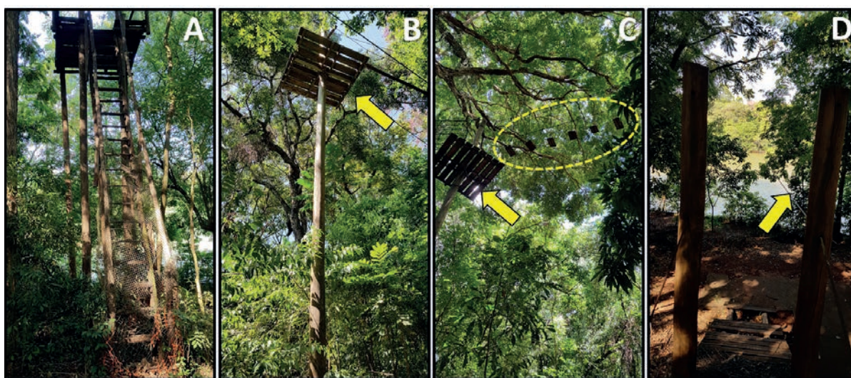
Figura 170. Parte da infraestrutura abandonada do arvorismo (A, B e C) e tirolesa (D).
